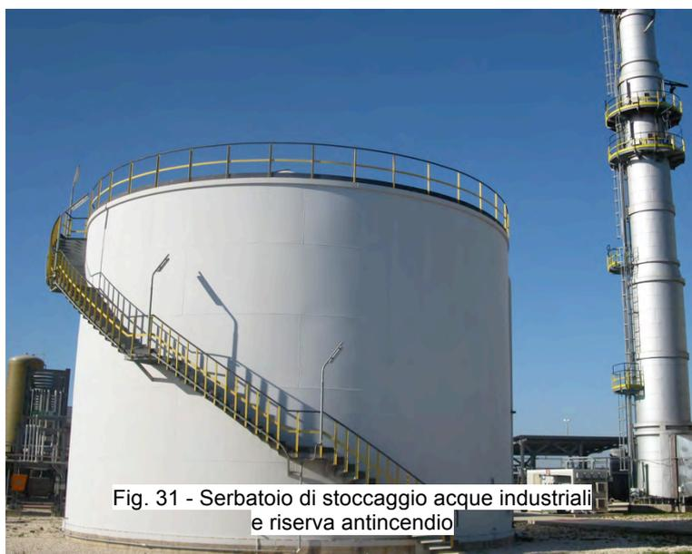
Fig. 31 - Serbatoio di stoccaggio acque industriali e riserva antincendio
