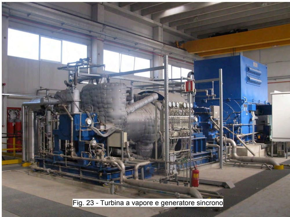
Fig. 23 - Turbina a vapore e generatore sincrono
