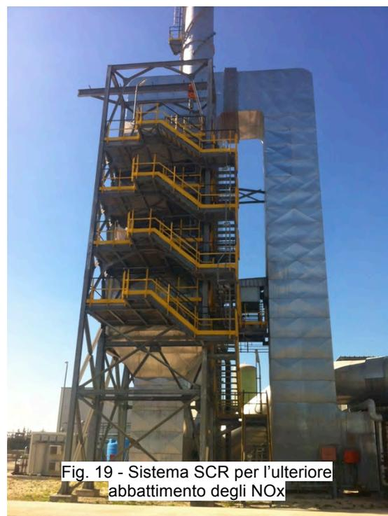
Fig. 19 - Sistema SCR per l'ulteriore abbattimento degli NOx
