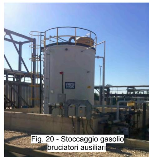
Fig. 20 - Stoccaggio gasolio bruciatori ausiliari
