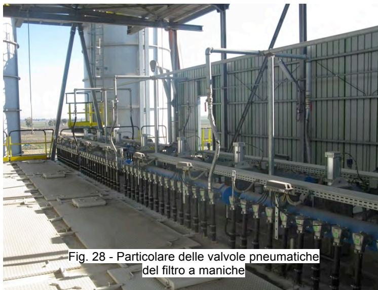
Fig. 28 - Particolare delle valvole pneumatiche del filtro a maniche
