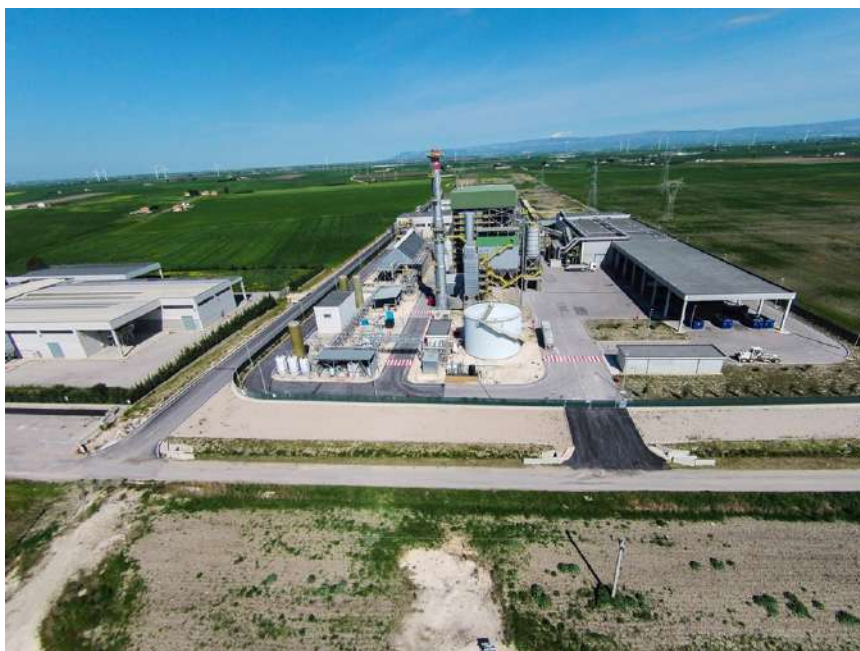
Fig. 38 Vista lato sud della Centrale Elettrica
