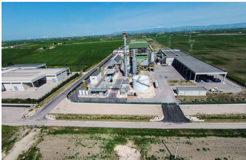
Fig. 7 Vista lato sud della Centrale Elettrica
