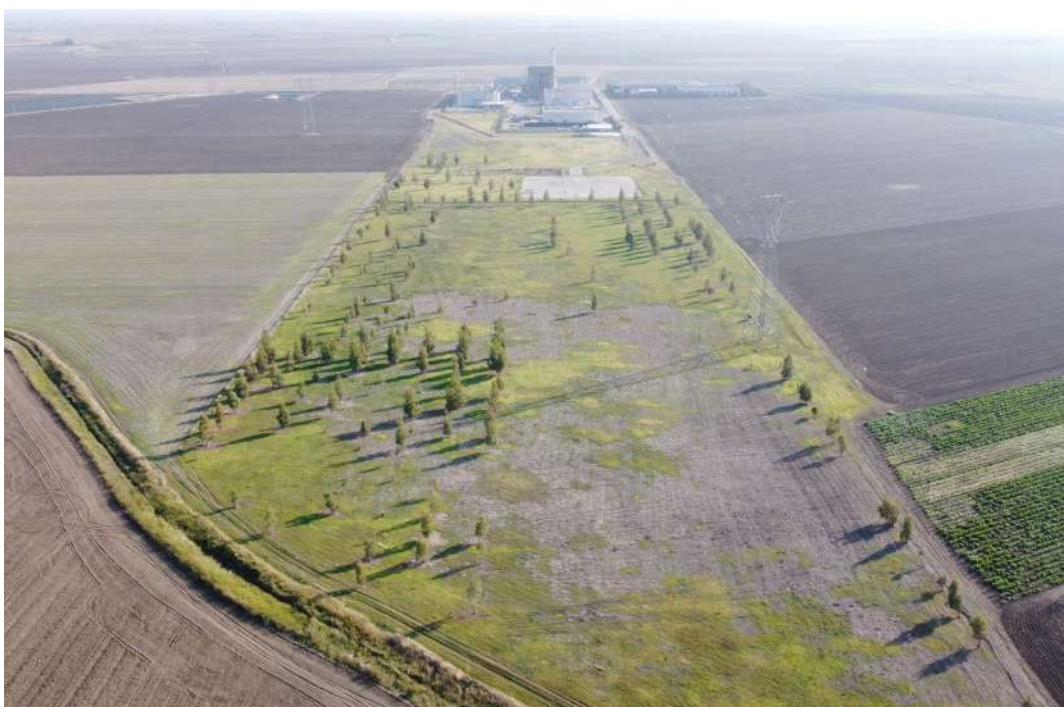
Fig. 13 Particolare della zona a verde lato nord-ovest
