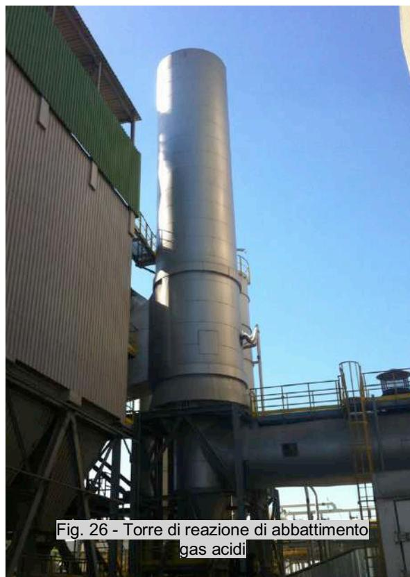
Fig. 26 - Torre di reazione di abbattimento gas acidi
