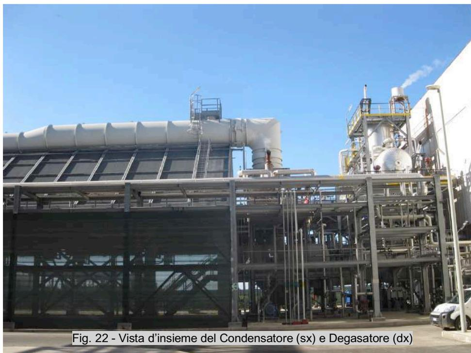
Successivamente il vapore, dalla turbina viene scaricato al "condensatore", da cui, una volta condensato può essere recuperato per essere inviato al generatore di vapore per un nuovo ciclo.
