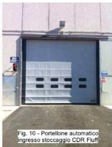
Fig. 10 - Portellone automatico ingresso stoccaggio CDR Fluff
