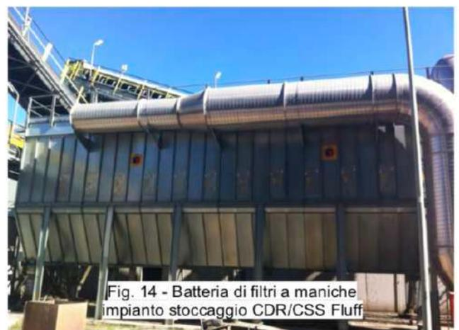
Fig. 14 - Batteria di filtri a maniche impianto stoccaggio CDR/CSS Fluff
