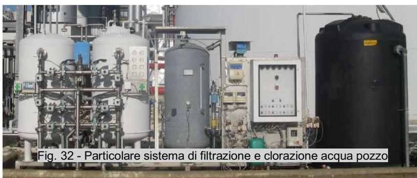
Fig. 32 - Particolare sistema di filtrazione e clorazione acqua pozzo
