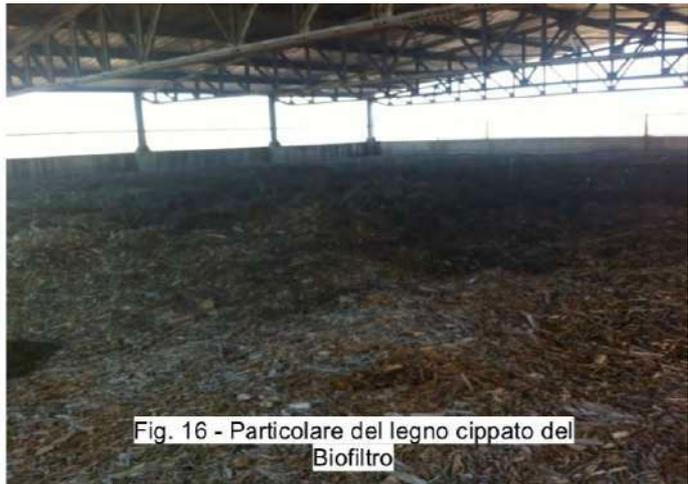
Fig. 16 - Particolare del legno cippato del Biofiltro
