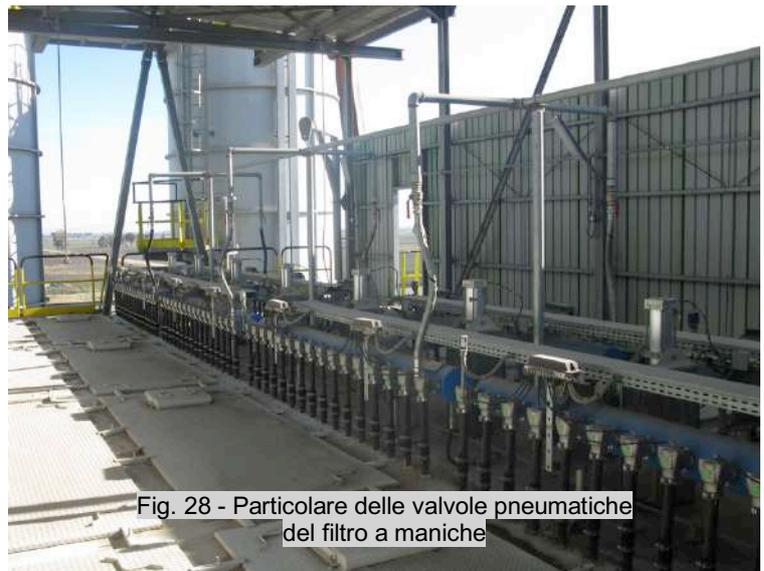
Fig. 28 - Particolare delle valvole pneumatiche del filtro a maniche
