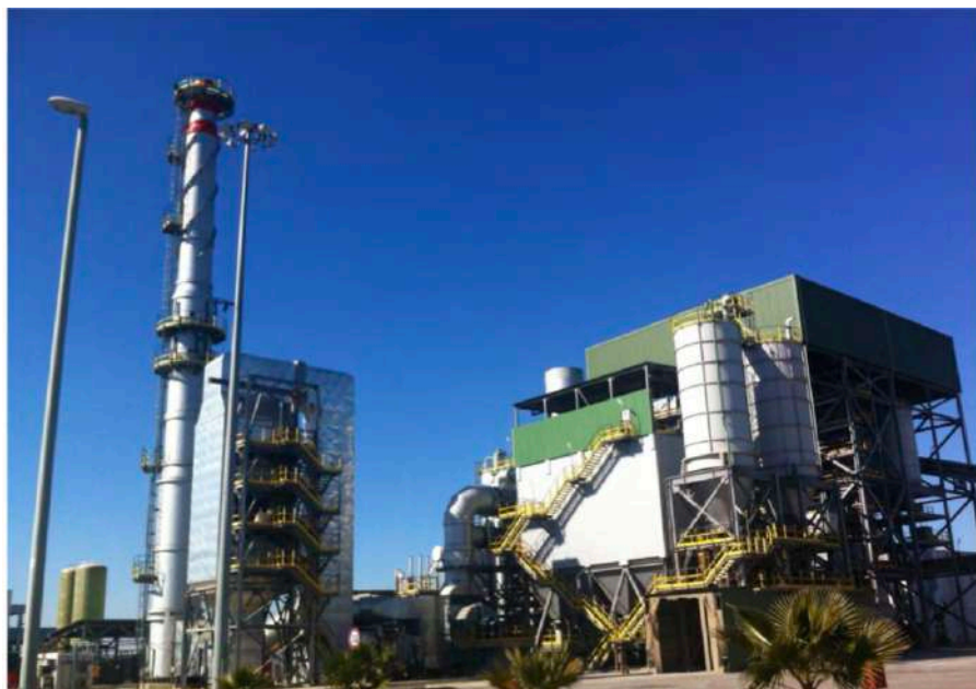
Fig. 2: Vista sud-est della Centrale termoelettrica
