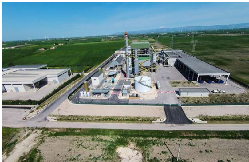
Fig. 6 Vista lato sud della Centrale Elettrica
